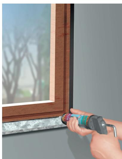
TEKADOM masilla acrílica monocomponente con base en dispersión acrílica, para el sellado de materiales porosos en espacios interiores. Soporta una dilatación del 10%.
